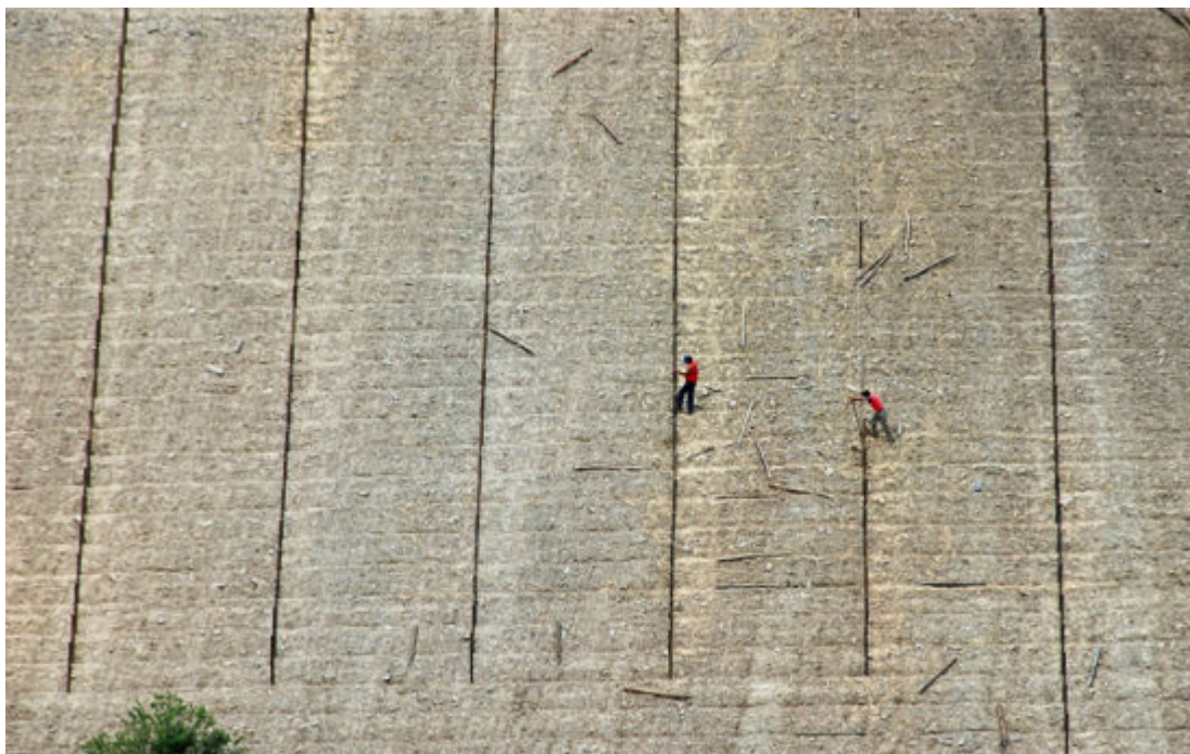
Colocação de estacas na Quinta da Marka – Gouvinhas 2008
